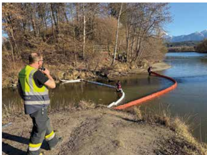
Mehrere Ölsperren wurden im Bereich des Seebacheinflusses gesetzt.
