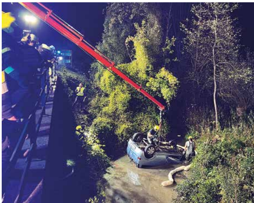
Das Fahrzeug wurde mit unseren Kran aus dem Bachbett gehoben und dann abtransportiert.
