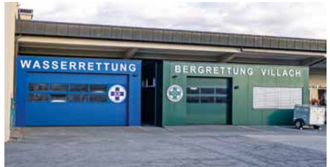
Auch die Räumlichkeiten der Wasserrettung und Bergrettung erhielten zusätzlichen Platz.
