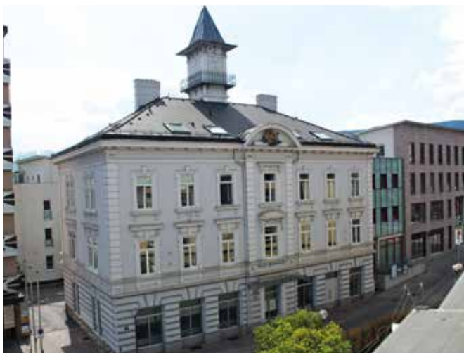
Das alte Rüsthaus am Hans-Gasser-Platz musste im Laufe der Jahre mehrere Male umgebaut werden.
