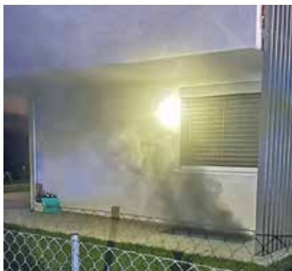
Rauch dringt aus den Lichtschächten
