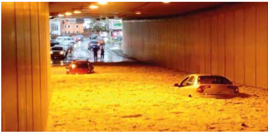
Unwetter vom 8. Juli 2015: Unterführungen und Straßensenken wurden unpassierbar; einige Fahrzeuge mussten geborgen werden.
