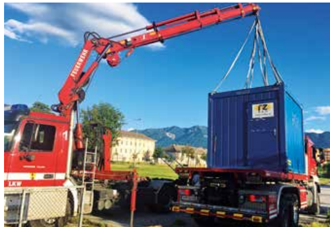
Kräfte unserer Wache beim Herstellen der Infrastruktur an den Parkplätzen und Wettkampforten.
