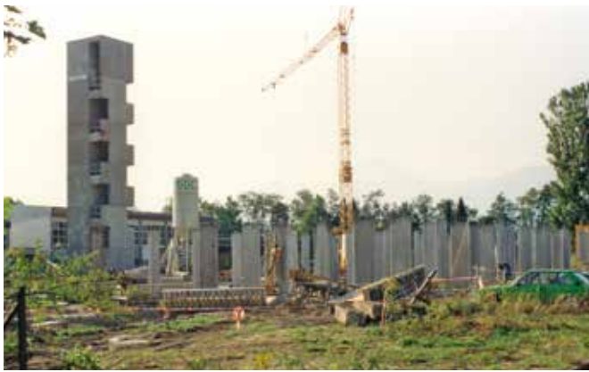
Imposant die Baustelle. Im Hintergrund der bereits errichtete Schlauch- und Übungsturm; vorne entsteht die Fahrzeughalle.
