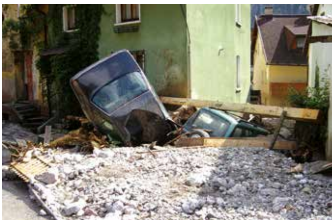
Die Ortschaft Ugowizza samt ihrer Infrastruktur wurde in weiten Teilen stark beschädigt.
