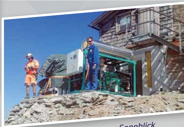
150 kVA-Aggregat-Einbau am Sonnblick
