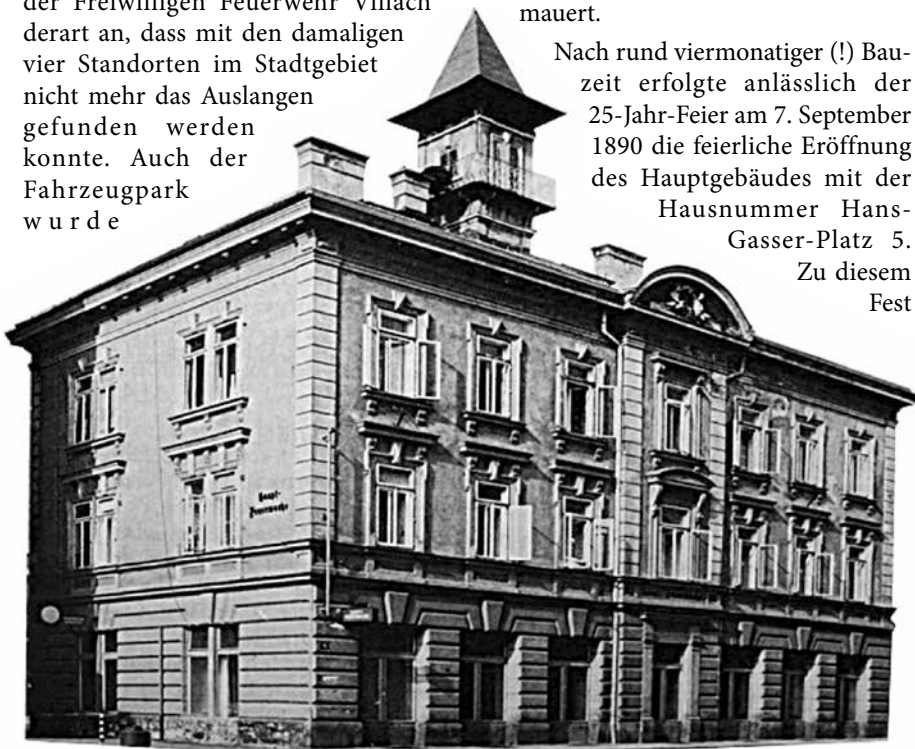
Das neue Rüsthaus am Hans-Gasser-Platz wurde in Rekordzeit fertig gestellt.
