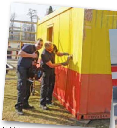
Schleifarbeiten bei unserem Wassercontainer
